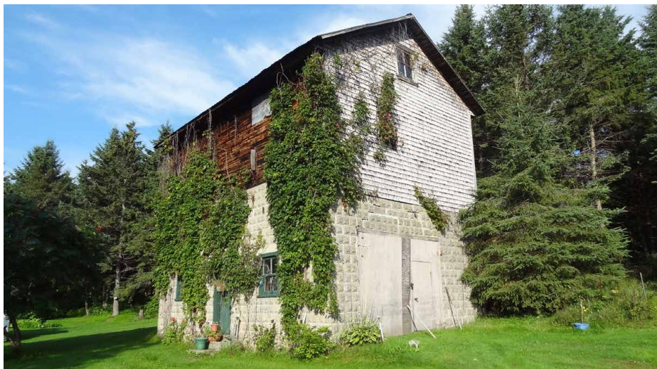
Ancien moulin à grains d'intérêt patrimonial à Saint-Méthode (Photo : Centre d'archives de la région de Thetford)
