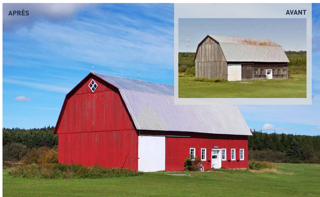
Exemple d'un bâtiment agricole bien entretenu et mis en valeur (Photo : Jérôme Grondin et Google Maps)
